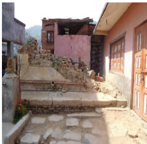
中庭にあった小屋が崩壊
