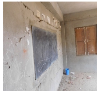
教室の壁にも亀裂が入っている
