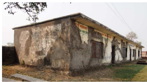
・改修工事中の小学校
