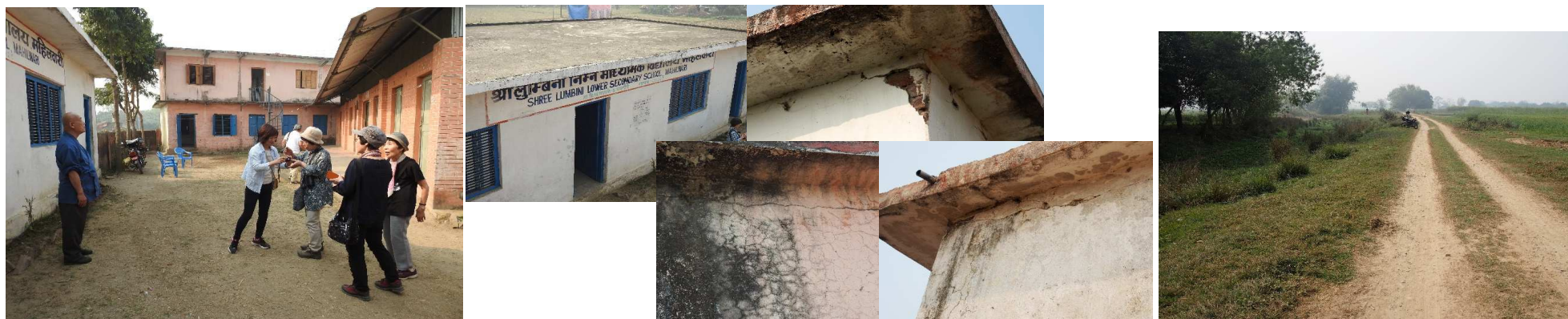
・小学校・図書室はいたるところに亀裂が入っていた。
